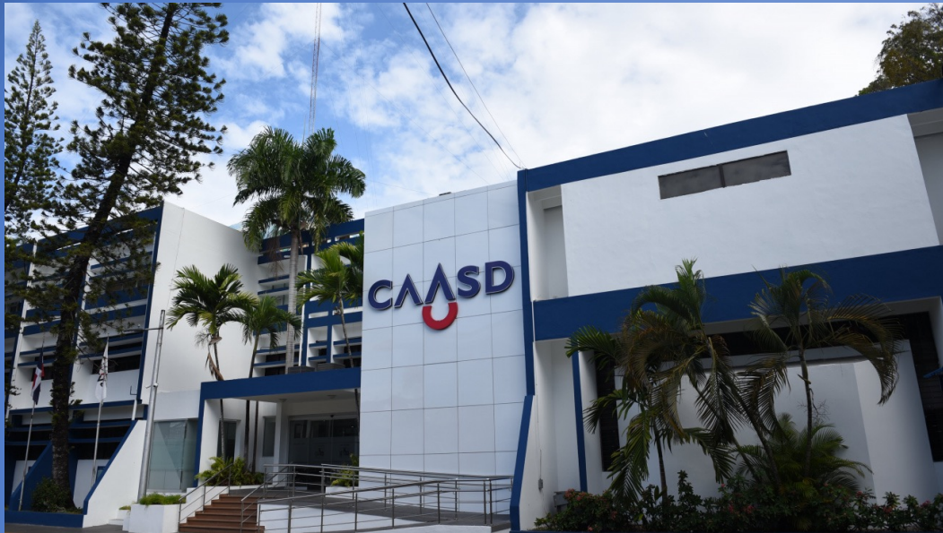
FACHADA ELABORADAS EN ACM , LETRAS EN ACRILICO CORTADAS , CON LUCES LED
