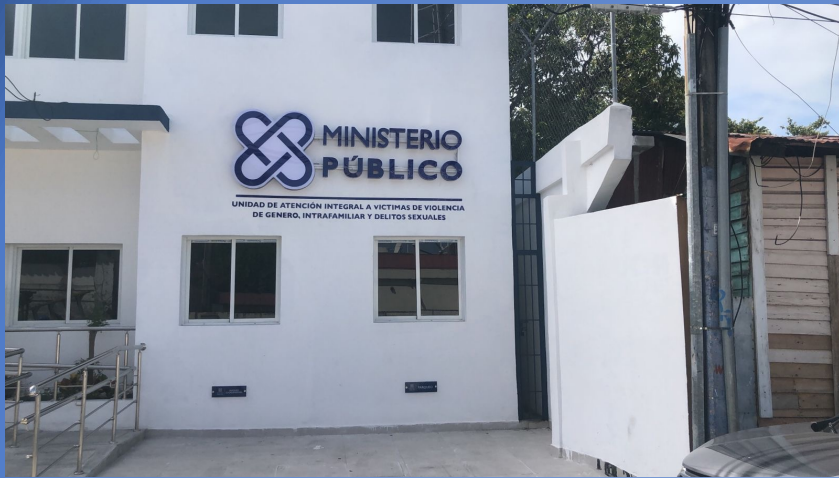
LETREROS PARA FACHADA , FABRICADO CON ESTRUCTURA METALICAS CON PERFILES , LUCES DE LED Y LETRAS EN ACRILICO CORTADAS
