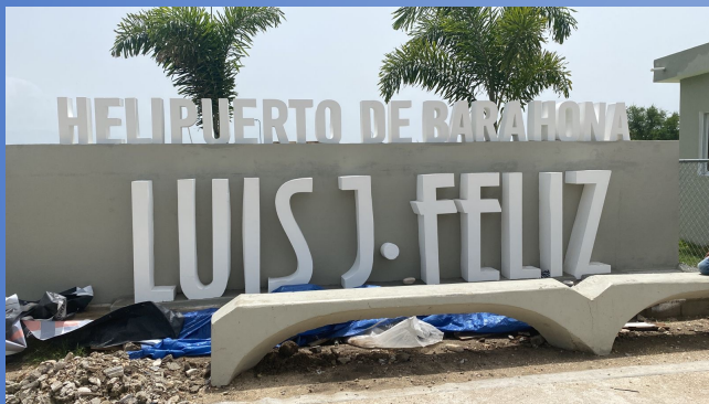
LETRERO EN HORMIGON ARMADO
